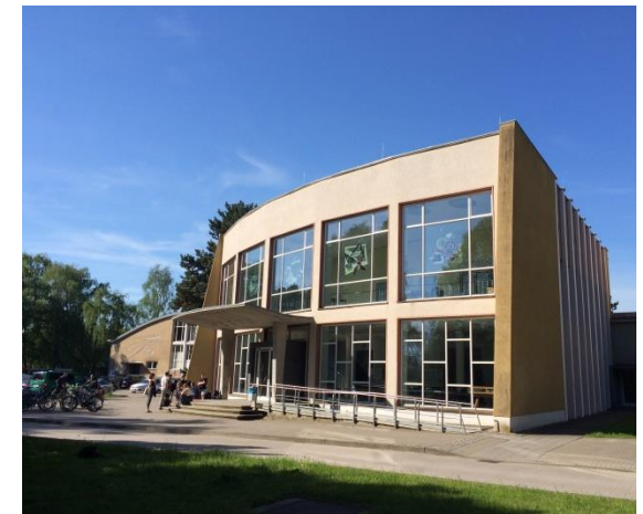
Großer Hörsaal Maschinenbau und Schiffstechnik
