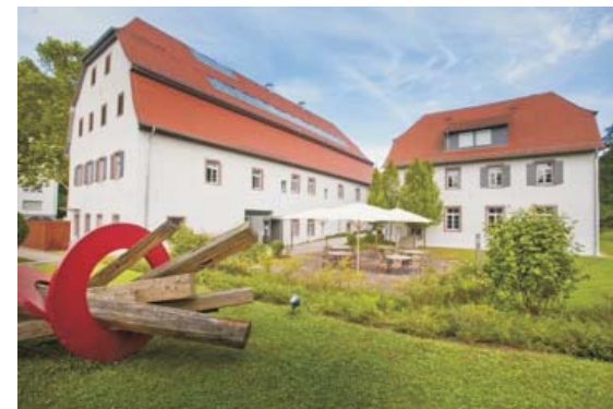
Tagungszentrum Buhlsche Mühle in Ettlingen
